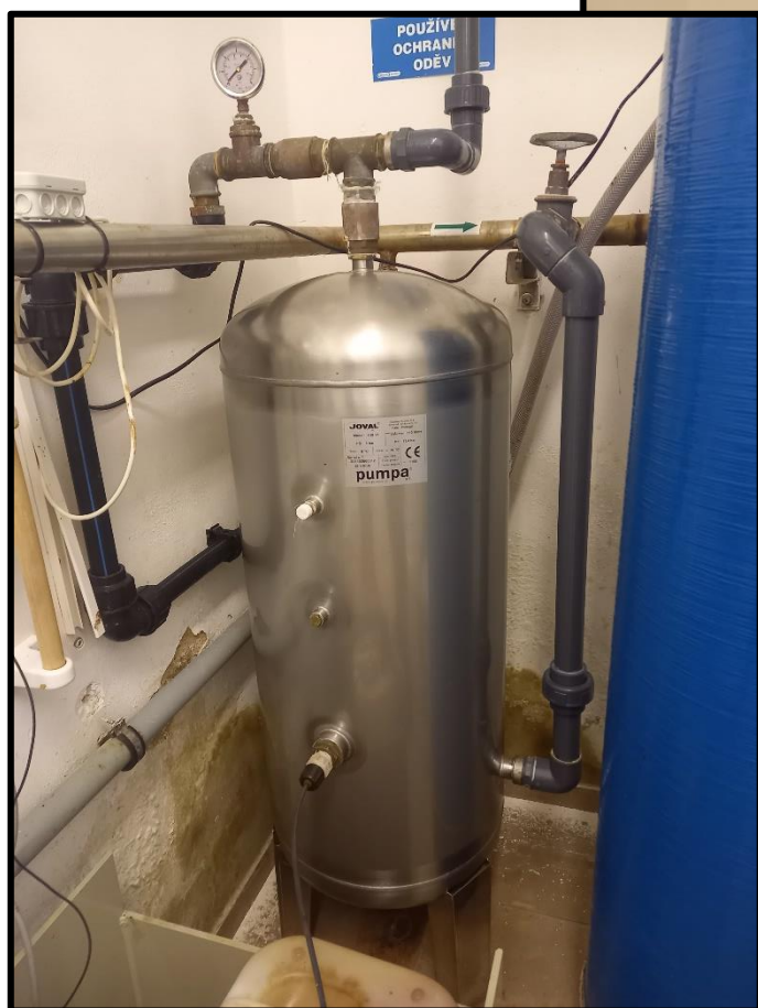
Obrázek 5 Úprava vody – reakční nádoba, filtr na odstranění zákalu
