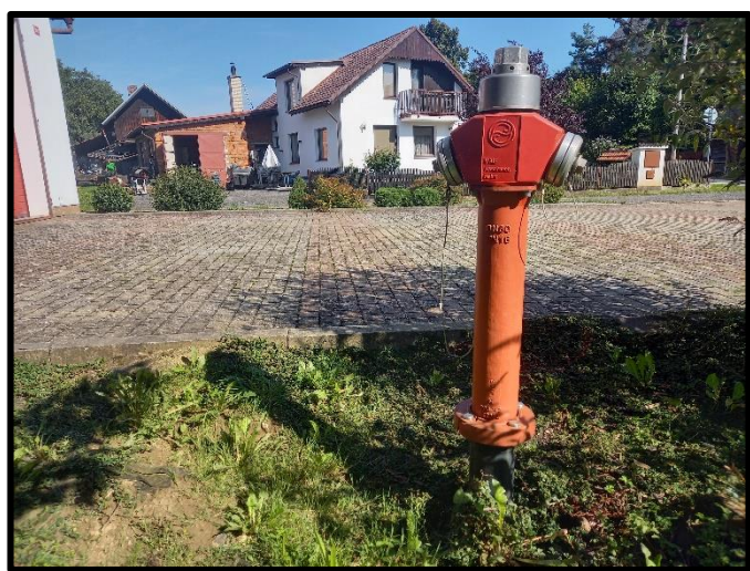
Obrázek 10 Nadzemní hydrant
